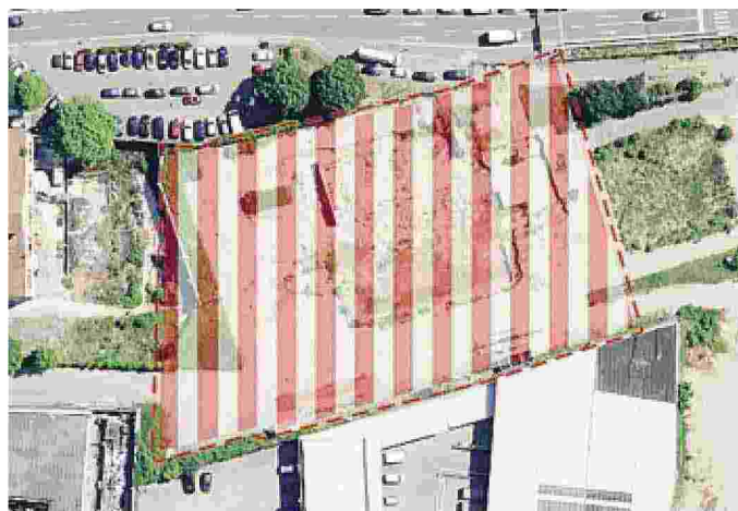
La zona della vecchia fabbrica dove è ancora presente amianto
